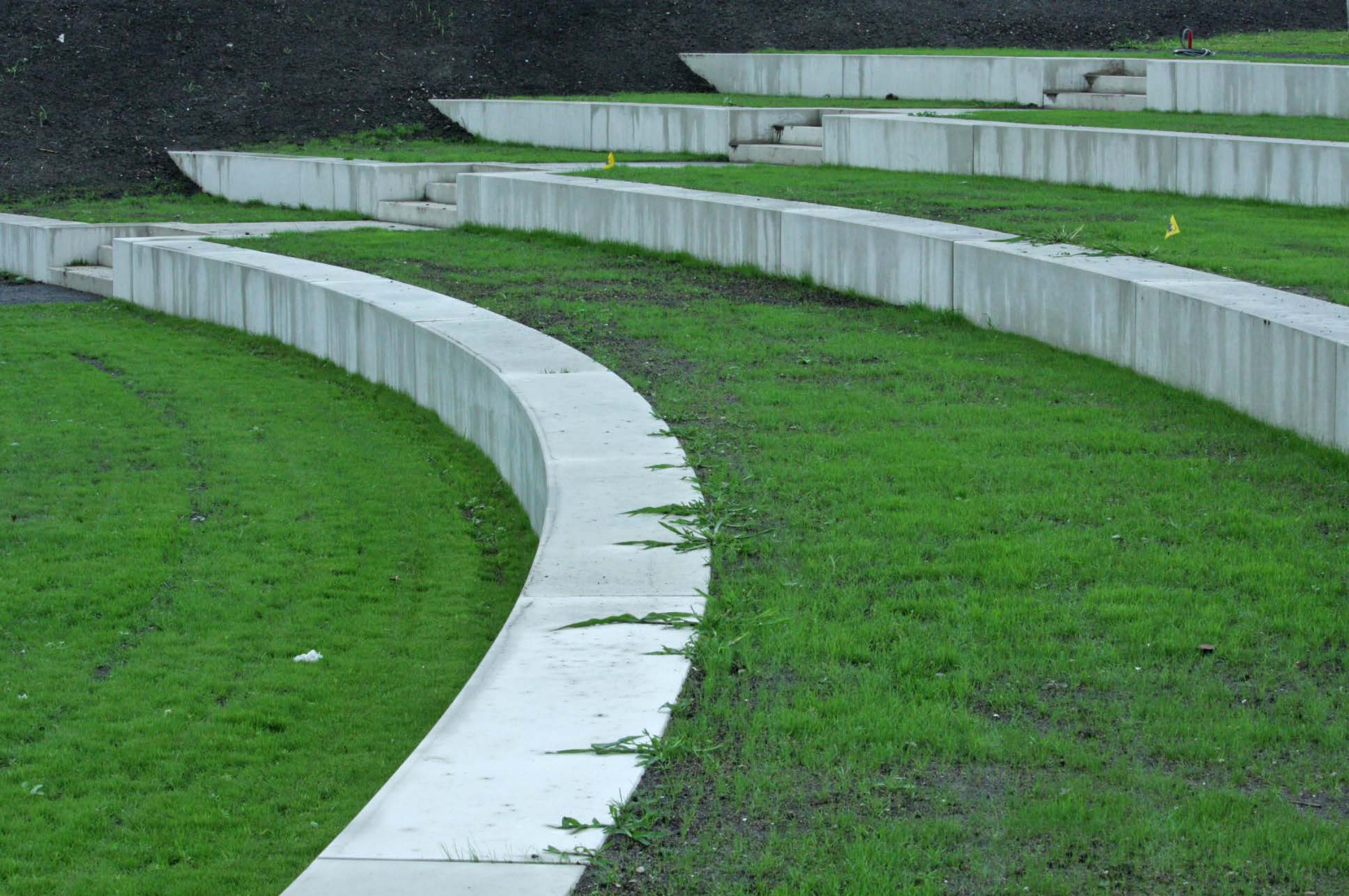
Gras_groeit_bij_betonnen_zitplaatsen_amfitheater_Fotograaf_Philip P. Kruijer
