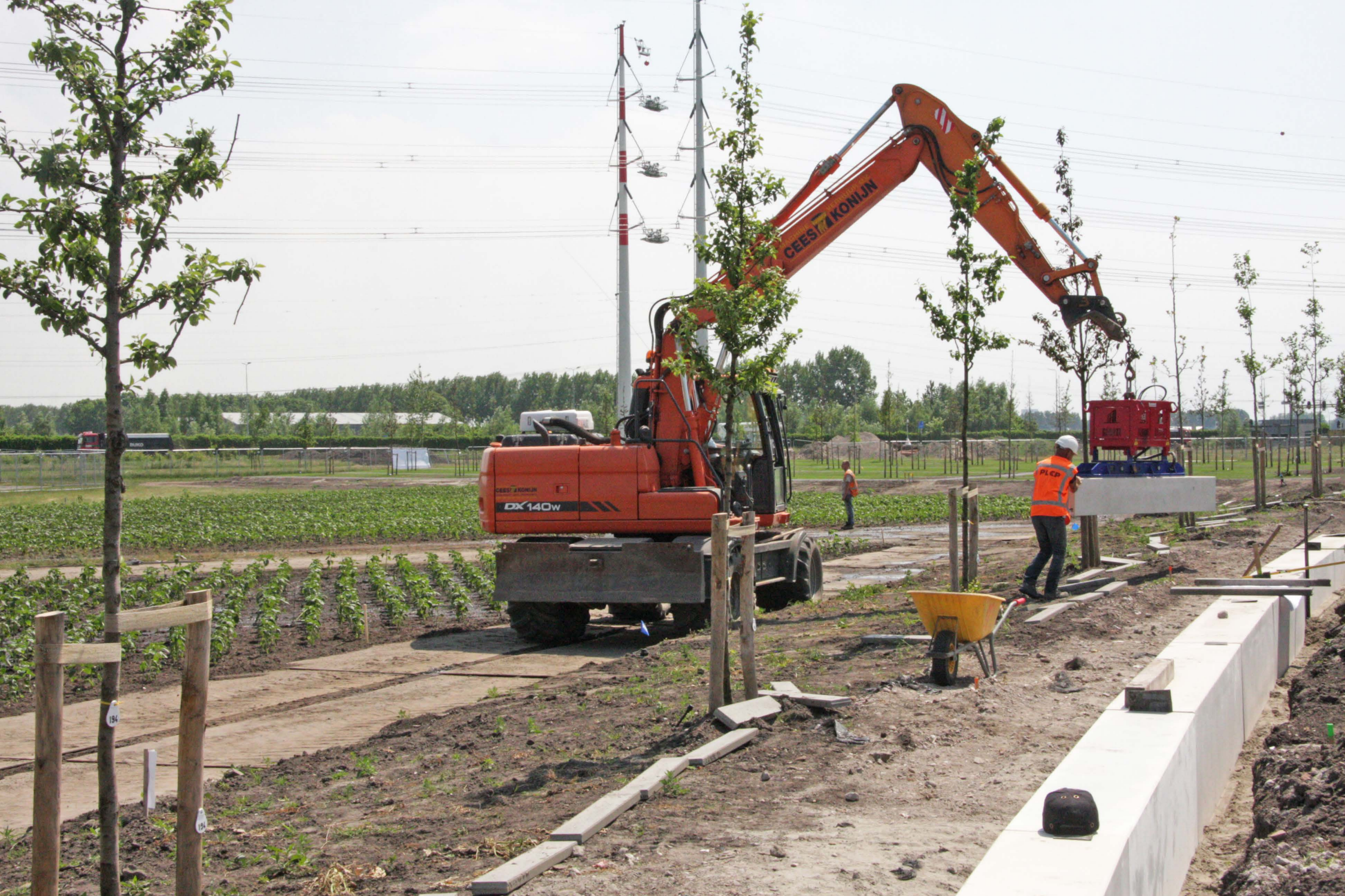
Betonelementen_buitenrand_trap_worden_geplaatst_Fotograaf_Philip P. Kruijer
